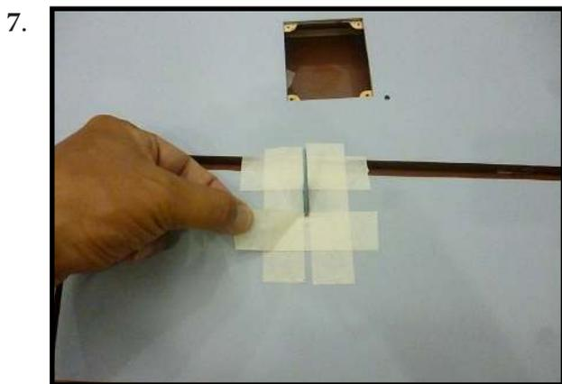
**INSTALLING THE AILERON SERVOS**
